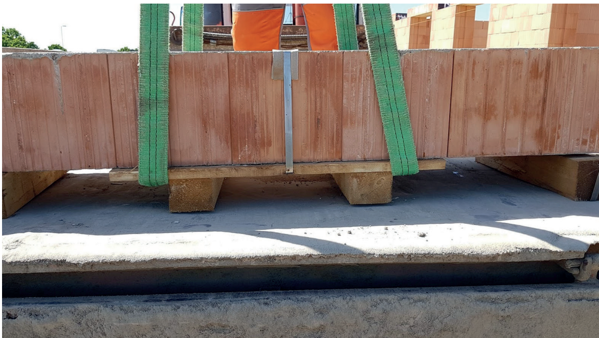
Obr. 6 Ukážka správnej manipulácie s prekladom – prevlečenie popruhov cez manipulačnú paletu.
