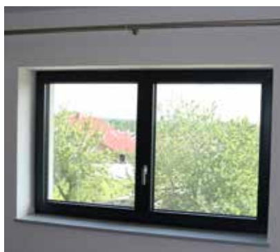
13 Pohľad na finálne zhotovenie stavebného otvoru z vnútornej strany.
