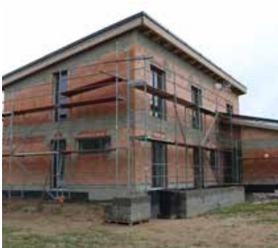
④ Príprava stavby pred omietaním.
