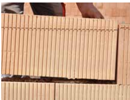
Brúsené tehly s výškou 249 mm, optimálna preväzba je ½ dĺžky tehly a minimálna 100 mm.
