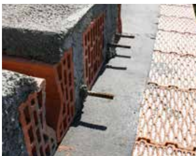
Uloženie stropov na asfaltový pás.
