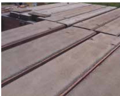
Podoprenie stropov MIAKO + nadvýšenie/kladenie stropných panelov.
