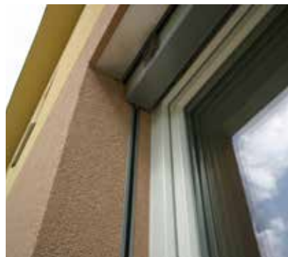
⑨ Pohľad na finálne zhotovenie stavebného otvoru so žalúziou v roletovom a žalúziom preklade HELUZ.
