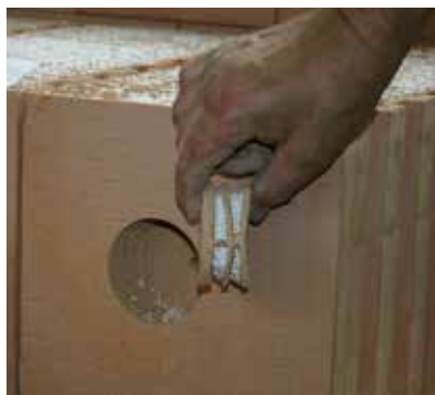
Na vrtanie otvorov elektroinštaláčnych škatúl sa odporúča použitie jadrového vrtáka.
