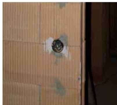
Na rozvody káblov napr. v priečkach je výhodné použiť diery v tehľách. Tým sa obmedzuje množstvo zhotovovaných drážok.
