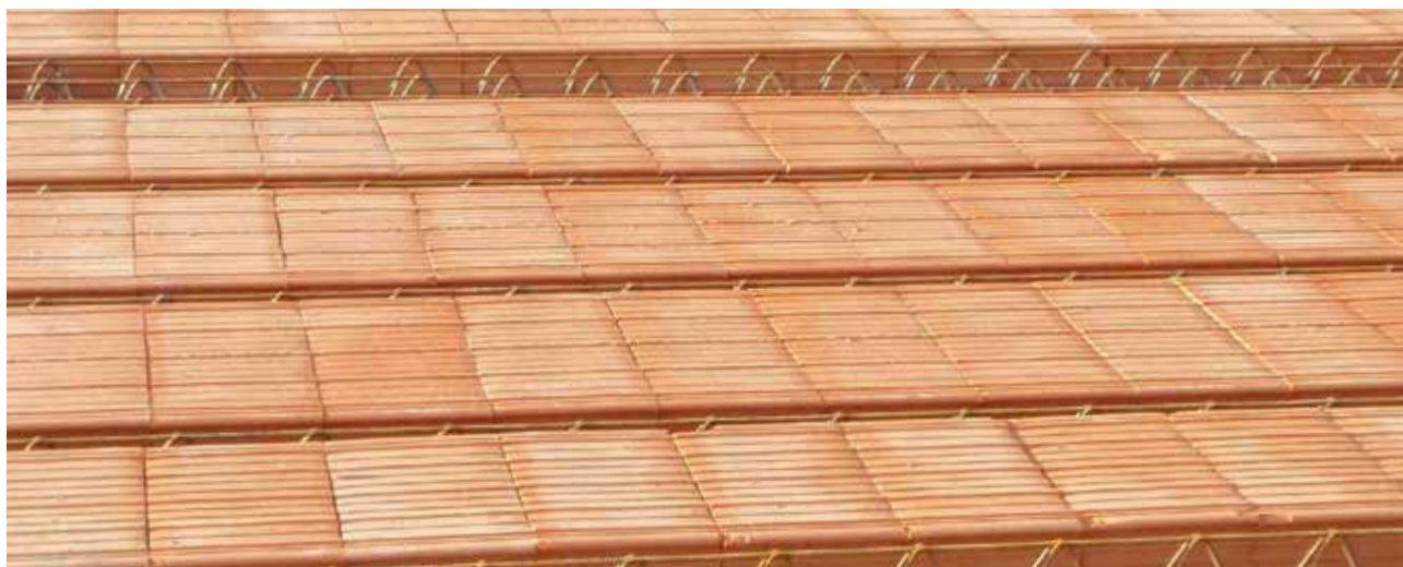
Pohľad na uložené nosníky a vložky (pred uložením KARI sietí)
