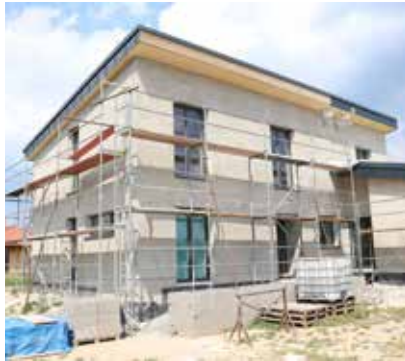
⑤ Zhotovenie jadrovej omietky (lahčenej alebo tepelnoizolačnej).
