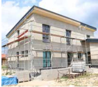
⑤ Zhotovenie jadrovej omietky (lahčenej alebo tepelnoizolačnej).
