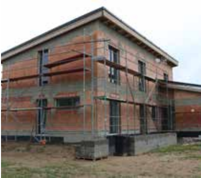
④ Príprava stavby pred omietaním. Pred omietaním je možné murivo vyspraviť a exponovanejšie miesta konštrukčných detailov ošetriť.
