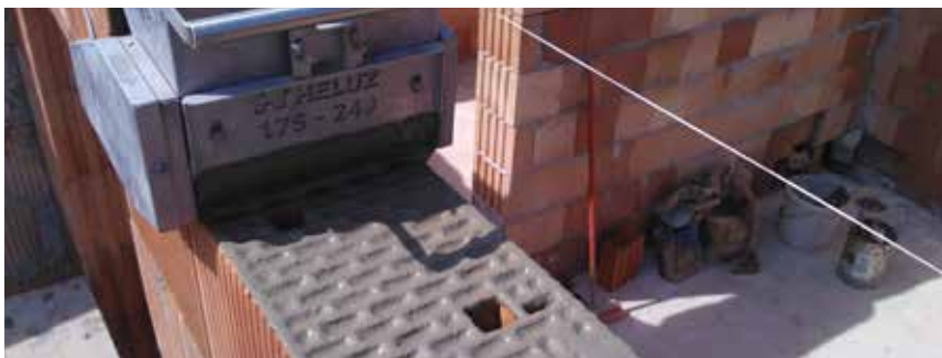
Murovanie vnútorných nosných stien.
