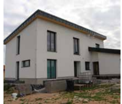
⑥ Dokončené vonkajšie omietky.
