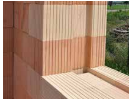
Doplnkové tehly (K, K-1/2, R) a príklad ich použitia v ostení a parapete
