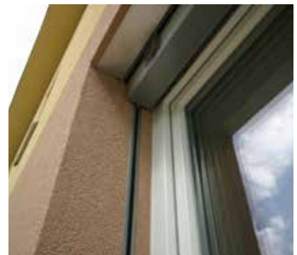
⑨ Pohľad na finálne zhotovenie stavebného otvoru so žalúziou v roletovom a žalúziom preklade HELUZ.
