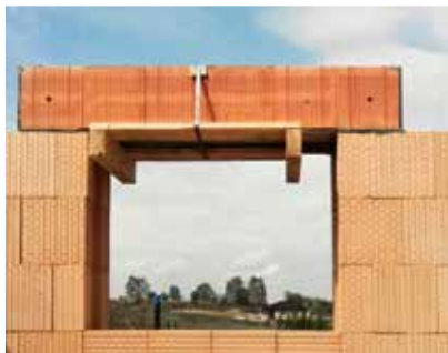
Uloženie prekladov (PREKLAD HELUZ FAMILY 3in1 nosný) do maltového lôžka.
