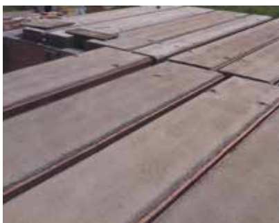
Podoprenie stropov MIAKO + nadvýšenie/kladenie stropných panelov.
