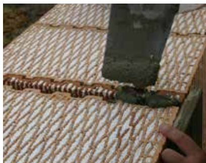
Medzera medzi tehľami sa musí vyplniť maltou alebo dorezom tehly a premaltovaním (v prípade murovania na PU penu výnimočne prepenením dvoma húsenicami).
