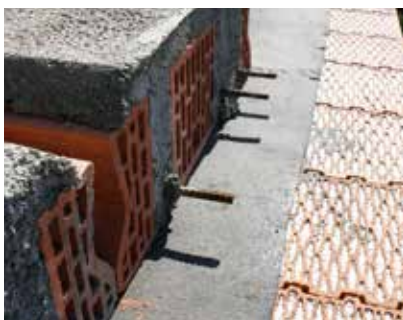
Uloženie stropov na asfaltový pás.
