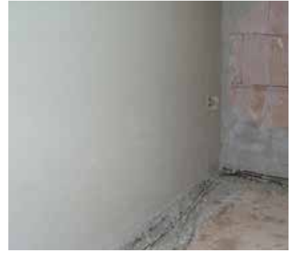
③ Vnútorné omietky sa zhotovujú od hrubej podlahy po korunu steny.
