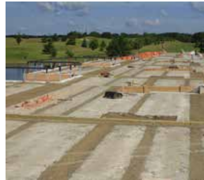
③ Na betonáž styčných škár medzi panelmi sa použije betón s maximálnou veľkosťou zrna 4 mm pevnostnej triedy min. C16/20 - XC1 mäkkej konzistencie S3 podľa ČSN EN 206+A2.
