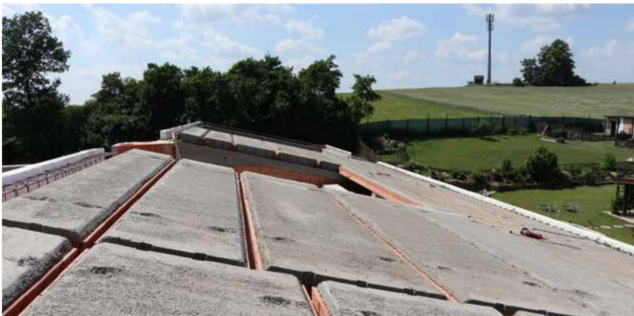
③ Na betonáž styčných škár medzi panelmi sa použije betón s maximálnou veľkosťou zrna 4 mm pevnostnej triedy min. C16/20 - XC1 mäkkej konzistencie S3 podľa ČSN EN 206+A2.
