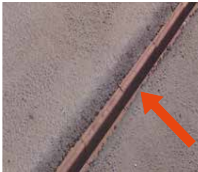
② Styčné škáry medzi stropnými panelmi sa musia pred betonážou (najmä keramická časť) riadne navlhčiť.
