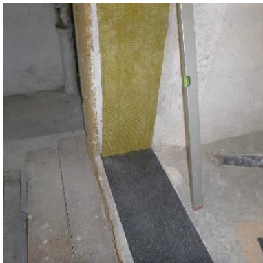
Stavba steny v laboratóriu
