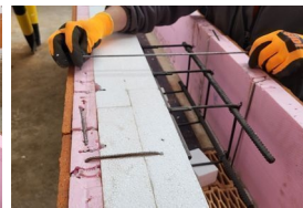
Pred betonážou sa vrchná strana spojí sponami, ktoré sa zaklopú do úrovne hornej hrany vencia.
