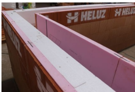
Tepelná izolácia je položená, skontroluje sa tesnosť styčných škár na vnútornej strane vencia.
