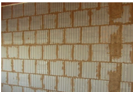
Zdivo z nepálených cihel se zdí na hliněnou maltu.
