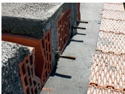
Uložení stropů na asfaltový pás.
