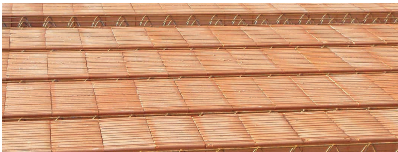
Pohled na uložené nosníky a vložky (před uložení KARI sítě)
