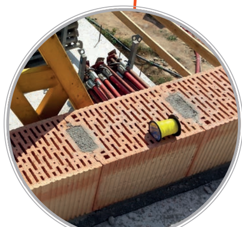
Vyplnění maltovacích kapes
