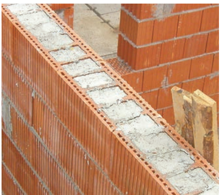
Zalévání dutin se provádí maltou či betonem max. po 1,0 m (4 řady cihel).
