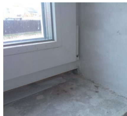
11 Pohled na styk parapetu a ostění po provedení omítek a před osazením finálního vnitřního parapetu.
