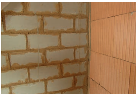
Hliněnou maltou se promaltovávají ložné i styčné spáry.
