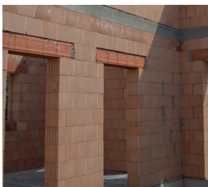
1 Ostění stavebních otvorů ve vnitřním zdivu se zakončuje drážkami popř. pery cihel.
