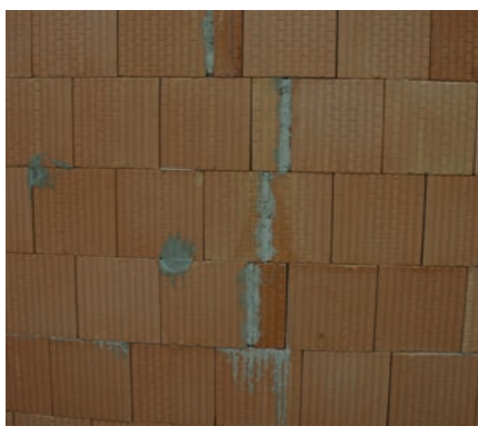
V místě dořezů cihel musí být spáry zcela vyplněny maltou.
