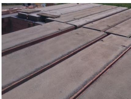
Podpěření stropů MIAKO + nadvýšení / po- kládka stropních panelů.
