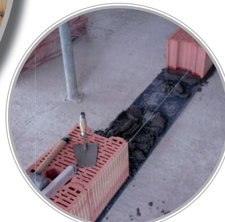
Založení na těžký asfaltový pás min. tloušťky 3 mm
