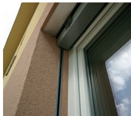
⑨ Pohled na finální provedení stavebního otvoru se žaluzií v roletovém a žaluziovém překlade HELUZ.
