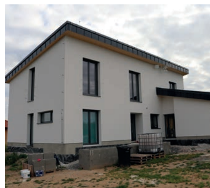
⑥ Dokončené vnější omítky.
