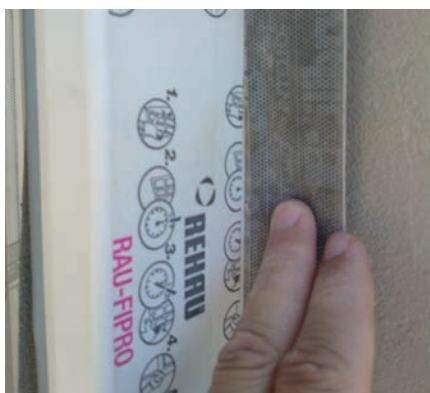
9 Přilepení okenních omítatelných pásek.
