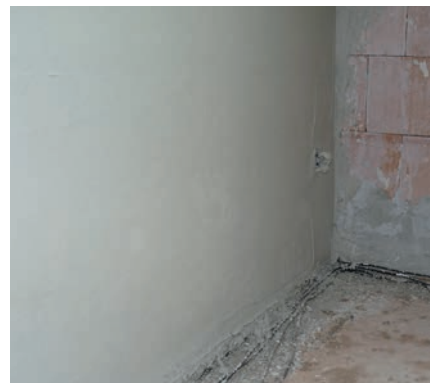
③ Vnitřní omítky se provádí od hrubé podlahy po korunu stěny.
