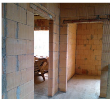
1 Ostění stavebních otvorů ve vnitřním zdivu se zakončuje drážkami popř. pery cihel.
