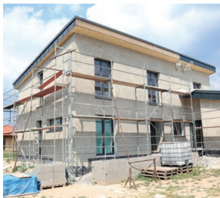
⑤ Provedení jádrové omítky (lehčené nebo tepelněizolační).
