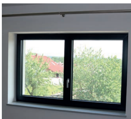
13 Finální pohled na provedení stavebního otvoru z vnitřní strany.
