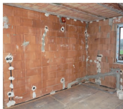
Pohled na zabudované elektroinstalační krabice a rozvedené kabely. Drážky pro rozvody vody a kanalizace musí být co nejménší.
