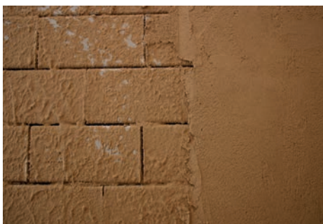
Zdivo se omítá hliněnou omítkou.
