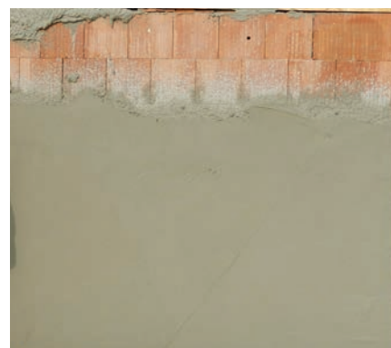
Omítání se obvykle provádí ve dvou nebo třech vrstvách, ručním nebo strojním způsobem.
