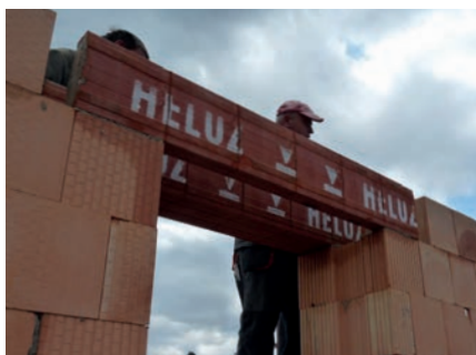
Uložení překladů (překlady HELUZ 23,8) do maltového lože.
