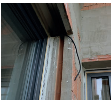
12 V případě použití roletových překladů je možné vyříznout v doplňkových cihlách drážku pro vodící lišty stínící techniky.
