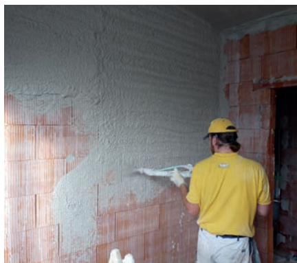
① Strojní nanášení vnitřní omítky.
