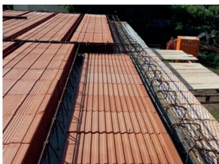
Provedení ztužujících věnců.
