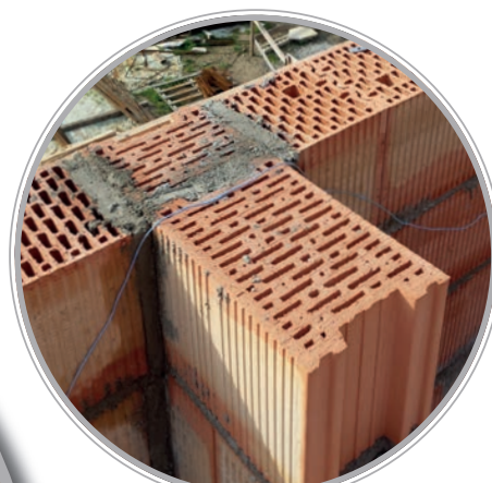
AKU zdivo se zpravidla vyzdívá do líce obvodového či vnitřního zdiva
