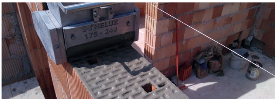
Zdění vnitřních nosných stěn.
